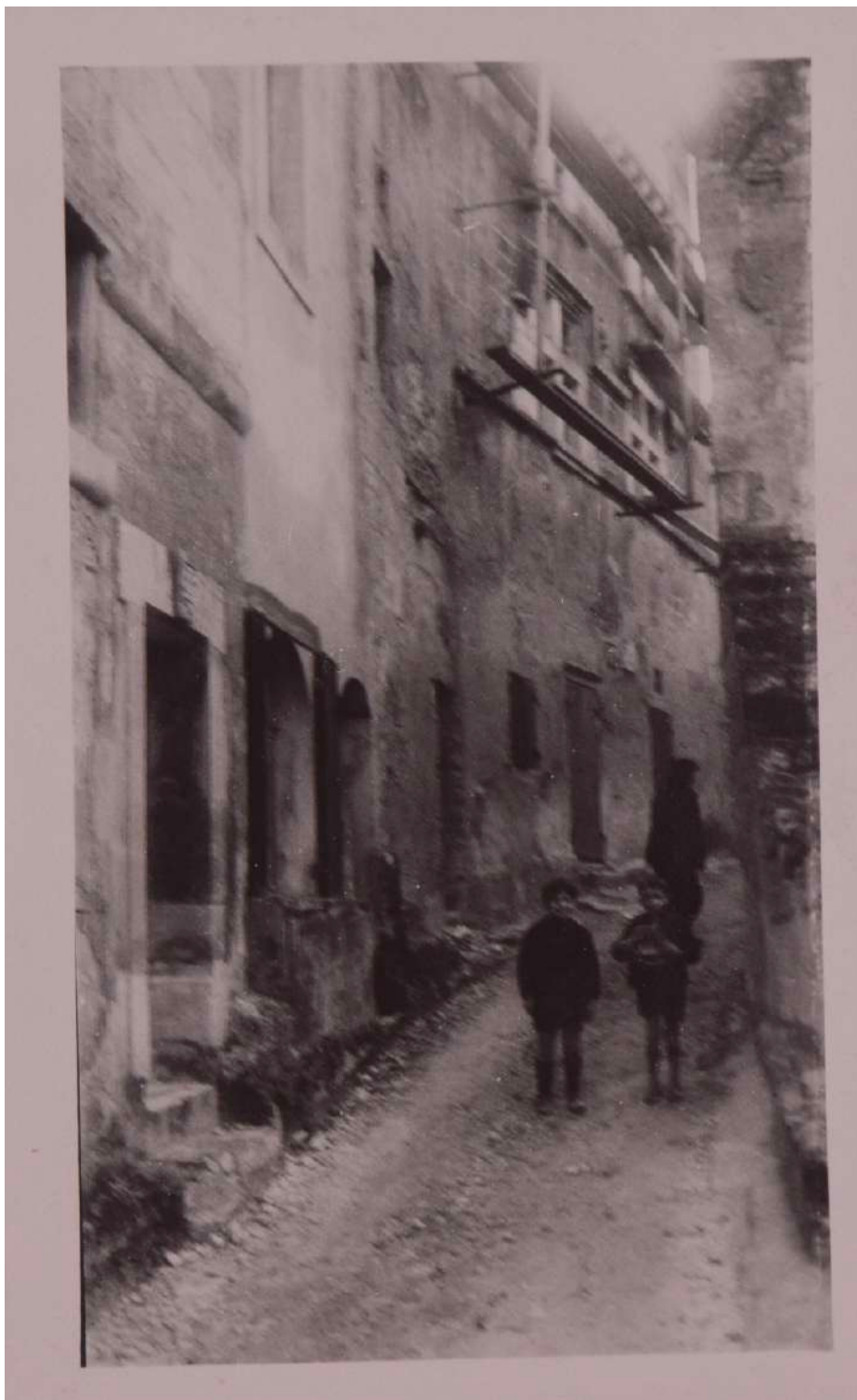
Hôtel de Brion pendant sa restauration, cira 1930
